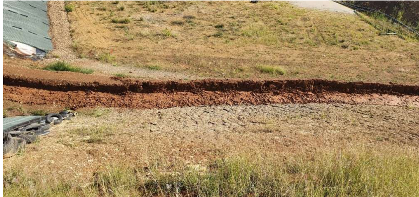
Photo 2 : curage du fossé
