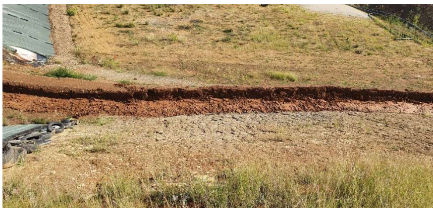
Photo 2 : curage du fossé
