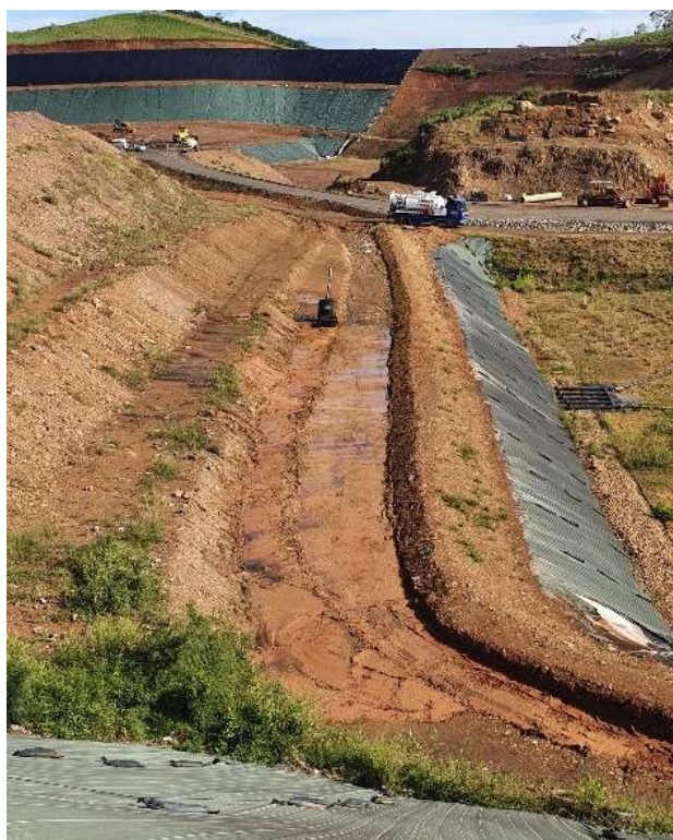
Photo 3 : Reprise des bas de talus du casier F1.
