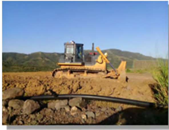
Figure 6 : Vue du bulldozer
