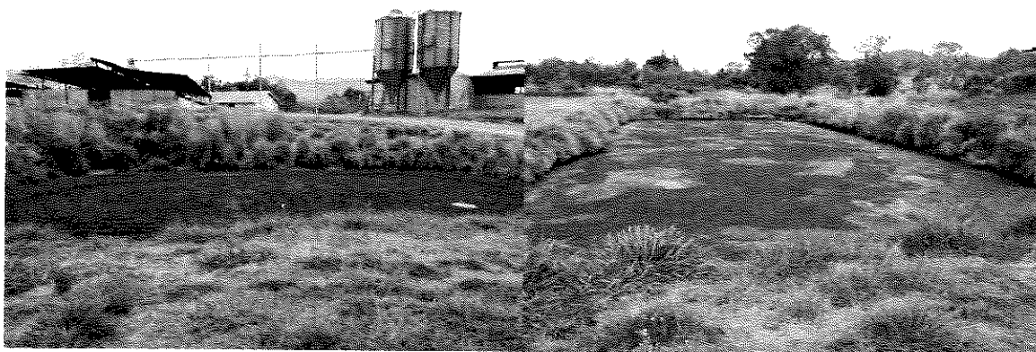
Figure 5 : prétraitement. Décanteur 1 à gauche, décanteur 2 à droite
