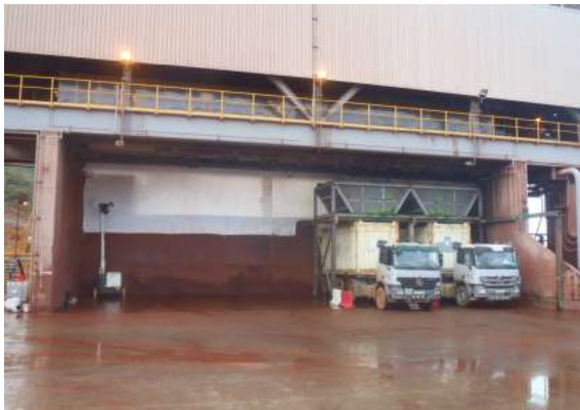
Figure 18 : Photo de la bâche installée sur l'unité DWP1
