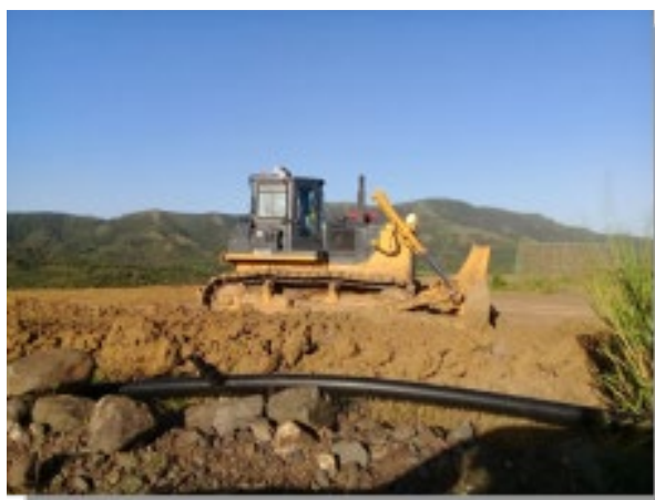
Figure 6 : Vue du bulldozer
