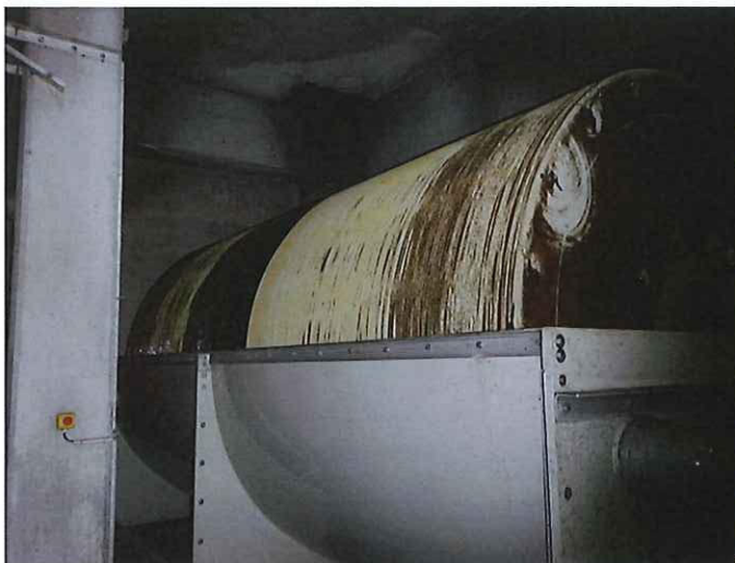
Photo 3 : Décanteur lamellaires avec flottants
