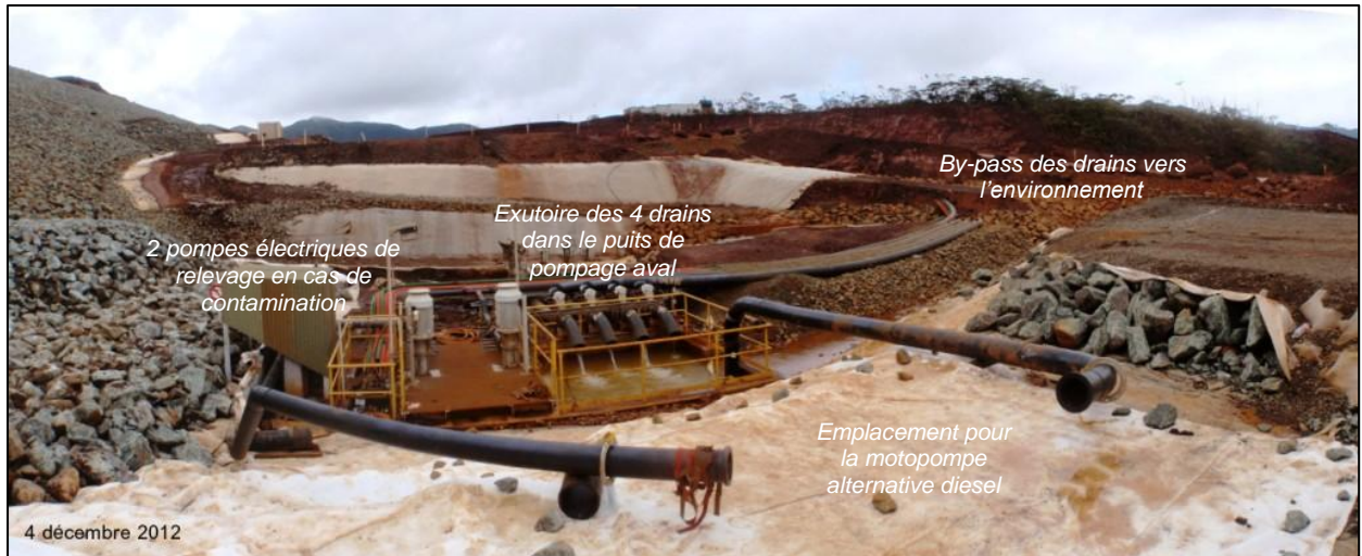
Exutoire des 4 drains dans le puits de pompage
