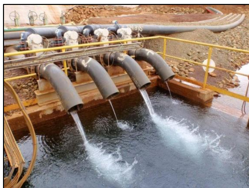
Exutoire des 4 drains dans le puits de pompage
