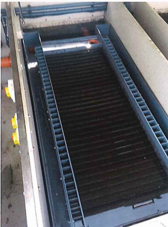
Photo 3 : Décanteur lamellaire
