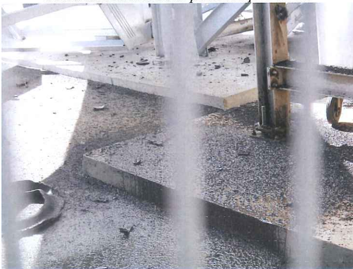
Photo 11 : Fines issues du traitement des pneumatiques au sol
