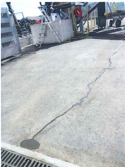
Photo 13 : Eau s'écoulant vers le caniveau de récupération des eaux de pluies et robinet d'incendie armé
