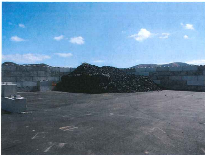
Photo 1 : Alvéole en cours d'achèvement dont le mur de séparation avec la seconde alvéole en cours de construction (à gauche)
