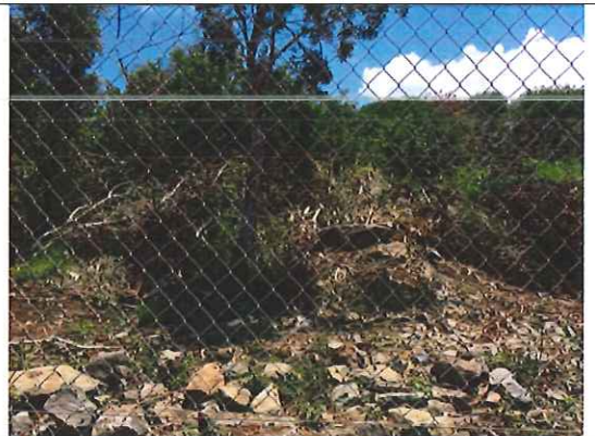
Photo 37 : Zone de végétation à évacué sur l'enrochement en sortie du bassin des eaux pluviales
