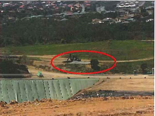
Photo 23 : Plateforme pour bâche souple de stockage CET
