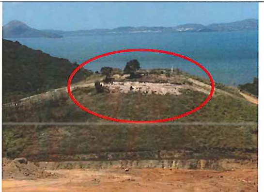
Photo 24 : Plateforme pour bâche souple de stockage draingom
