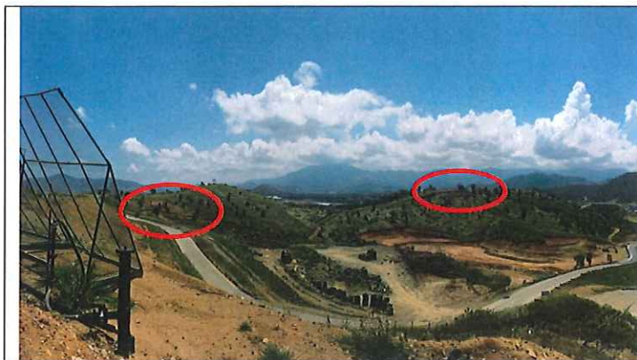
Photo 25 : Plateforme pour bâche souple de stockage proximité du stock historique
