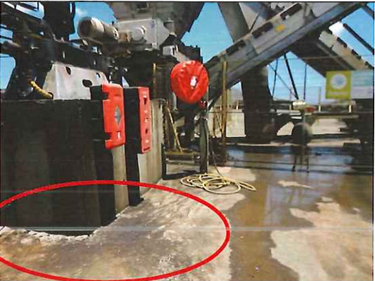
Photo 21 : Ria et extincteurs de la plateforme draingom et vue sur l'épanchement d'huile sous la grue
