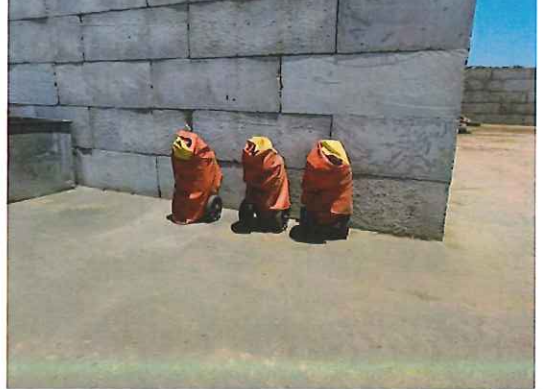
Photo 20 : Extincteurs 50 kg sur la plateforme Draingom
