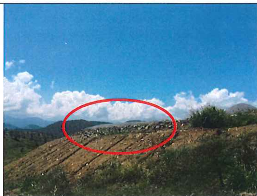
Photo 26 : Plateforme pour bâche souple de stockage montée entre les casier A et B
