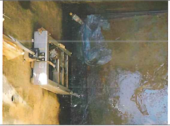
Photo 33 : Regard en sortie de bassin avec vanne fermée et écoulement depuis le bassin des eaux de pluies
