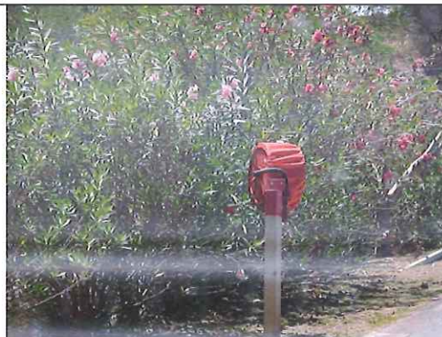
Photo 8 : RIA de la déchetterie face devant la voie d'accès
