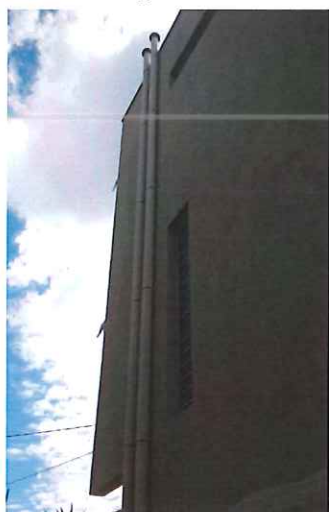
Photo 5 : évacuation des rejets en toiture
