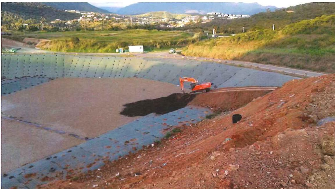
Comme pour les précédentes mises en exploitation, la cendre ne sera pas mise en place avant quelques mètres de hauteur de déchets (environ 3m), afin de ne pas risquer de colmater le massif drainant.
