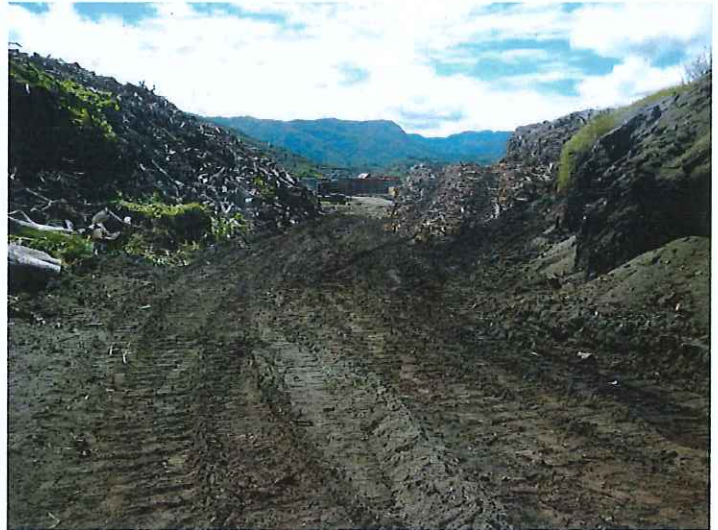
Figure 2: Agrandissement de la section de passage entre le tas de déchets de bois et le tas de scorie
