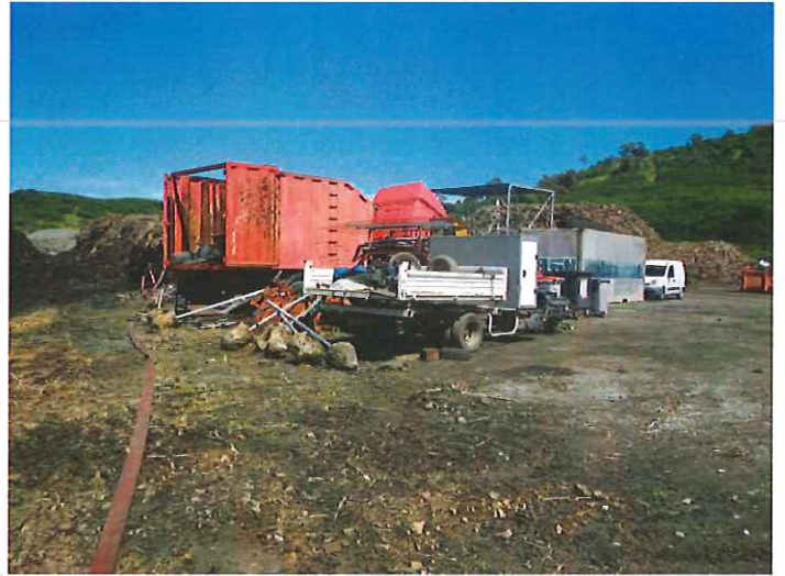
Figure 8: Emplacement de la future aire de lavage occupé
