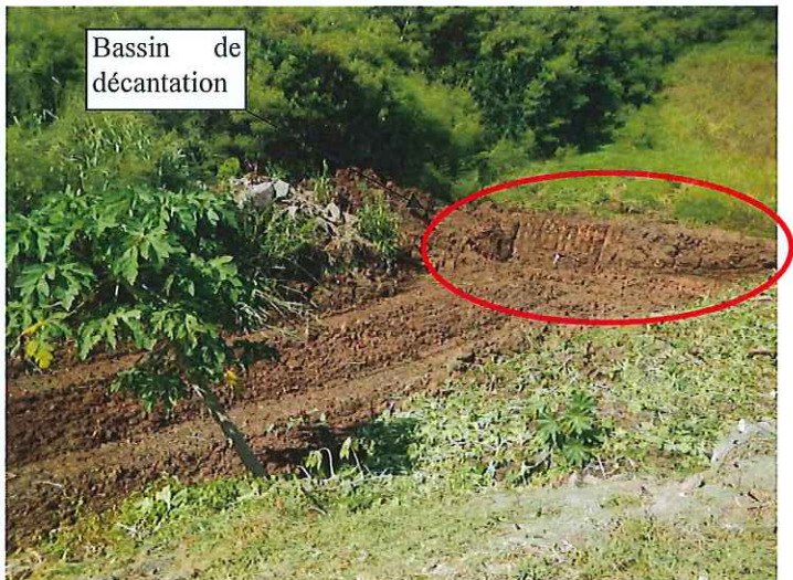
Figure 6 : Fossé de la zone de remblaiement et bassin de décantation au Sud du site
