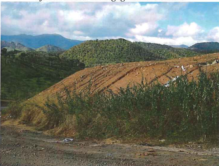
Photo 3 : Ravines sur les flancs de B
