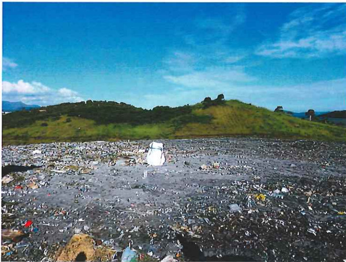
Photo 1 : Cheminée lixiviats recouverte dans l'alvéole C2 afin de limiter les dégagements d'odeurs
