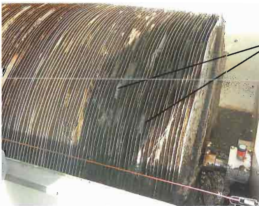
Figure 3: Présence de graisses en tête de biodisques
