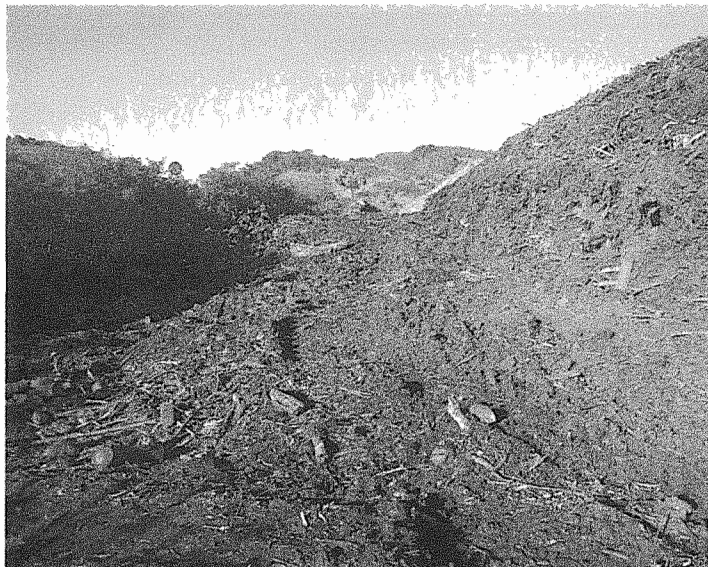
Figure 2: Début des travaux de déplacement tas déchets verts pour clôture
