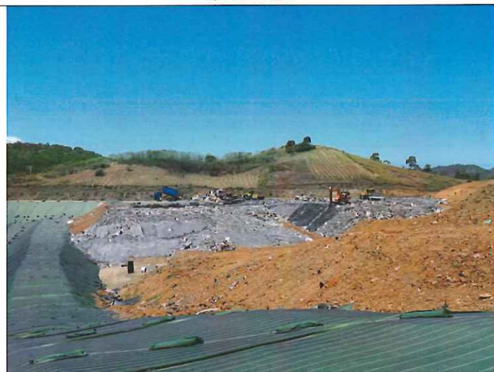
Photo 12 : Vue sur l'alvéole C2 en cours d'exploitation
