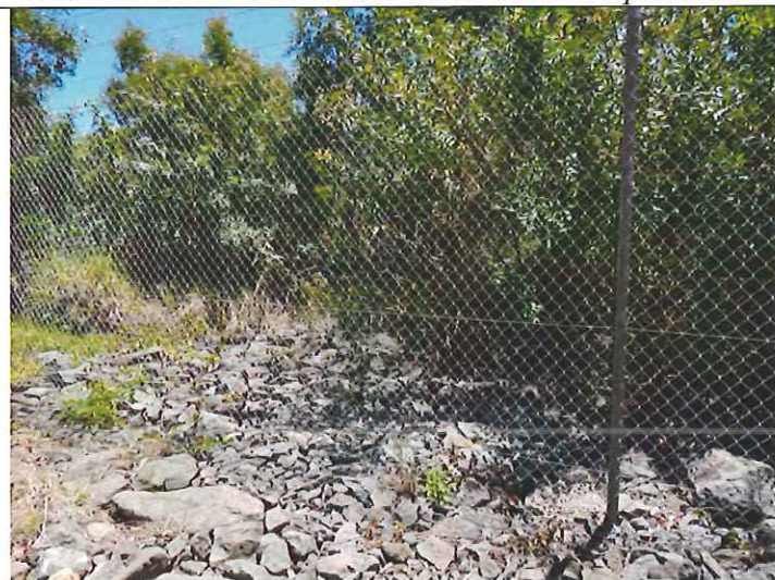
Photo 14 : Cailloutement en sortie de bassin des eaux pluviales
