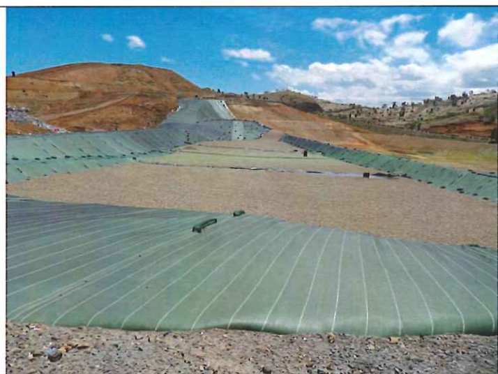
Photo 11 : Vue sur l'alvéole D1
