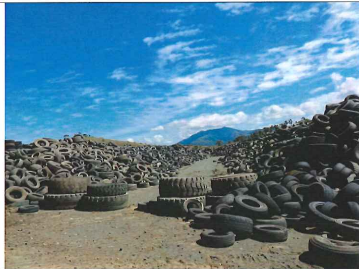
Photo 10 : Mise en place en cours de d'une tranchée entre les pneumatiques afin de pouvoir laisser passer un véhicule de secours
