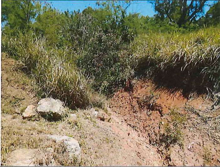
Photo 15 : Point de rejet des eaux des bassins d'eaux pluviales au niveau de la route RM22
