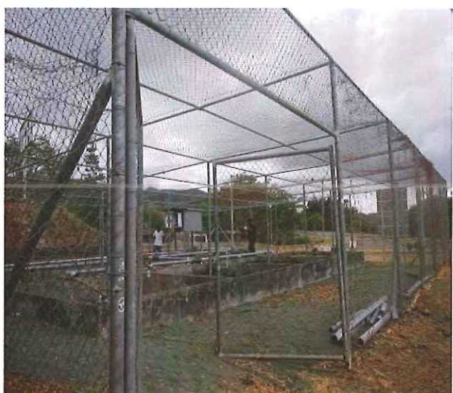
Clôture et portail à cadenas
