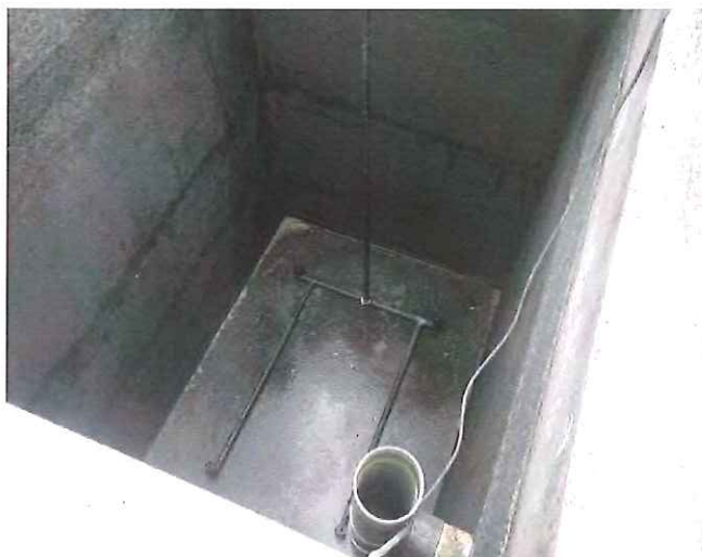
Silo à boues
