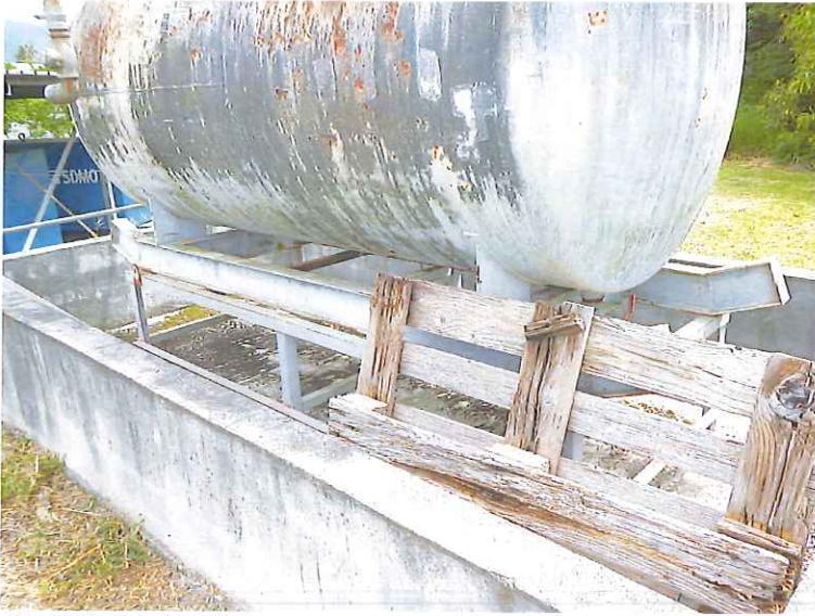
Cuve de stockage alimentant les groupes électrogènes à entretenir et évacuer la palette
