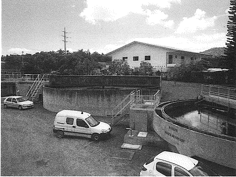
Photo 1 : construction voisine en cours à proximité de la station d'épuration
