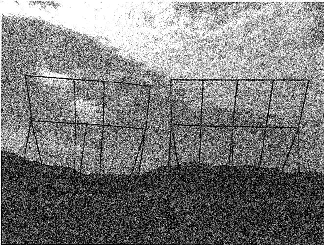
Photo 1 : Cages anti-envols réhabilitées
