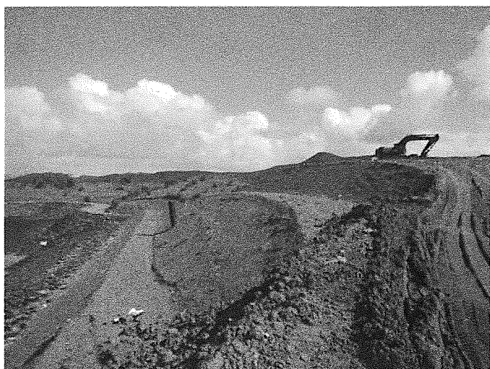
Travaux de modelage
