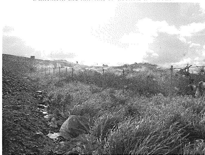
Rampe anti-odeur en fonctionnement
