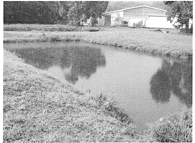
Figure 12 - Bassin de lagunage tertiaire
