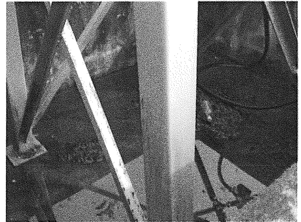
Figure 6 - Fond de la cuve de rétention du stockage aérien de gasoil
