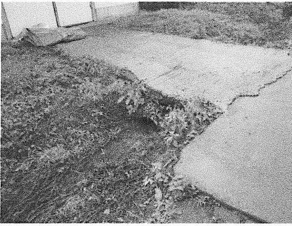
Figure 7 - Caniveau entourant un poulailler obstrué par la boue
