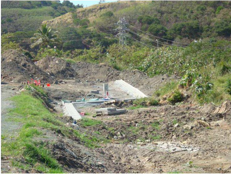
Photo 1 : travaux en cours sur plateforme des balayeuses
