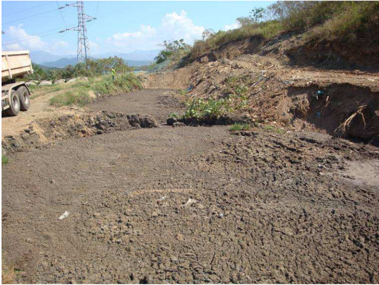
Photo 7 : bassin de stockage temporaire des boues
