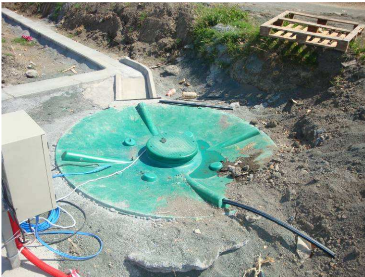
Photo 3 : installation de la cuve et du tableau électrique sur plateforme des balayeuses
