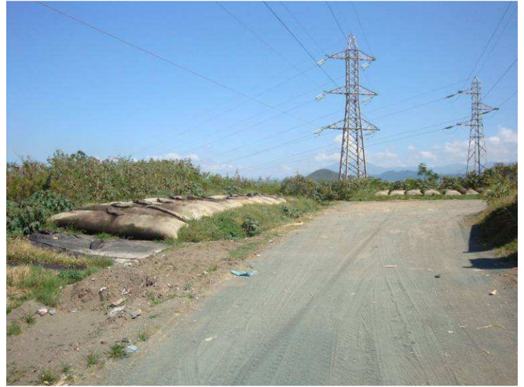
Photo 8 : zone de séchage des boues surmontées des lignes électriques d'ENERCAL
