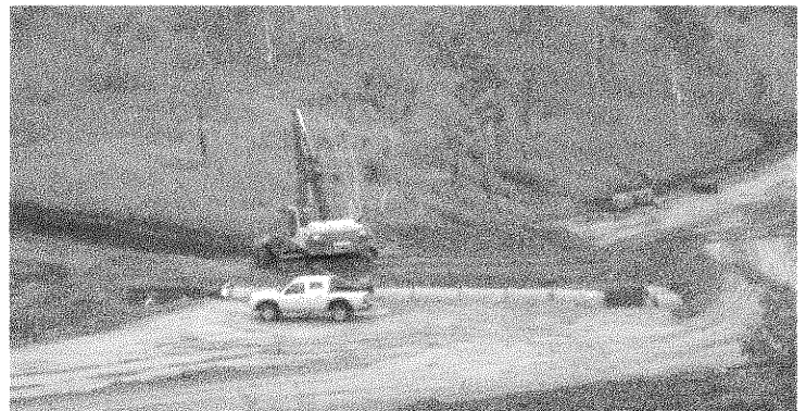
Photo 9 : réalisation de la route périphérique de l'ISD
