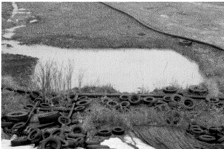
Photo 2 : ancienne rétention utilisée pour la fuite des eaux provenant de l'alvéole B2
