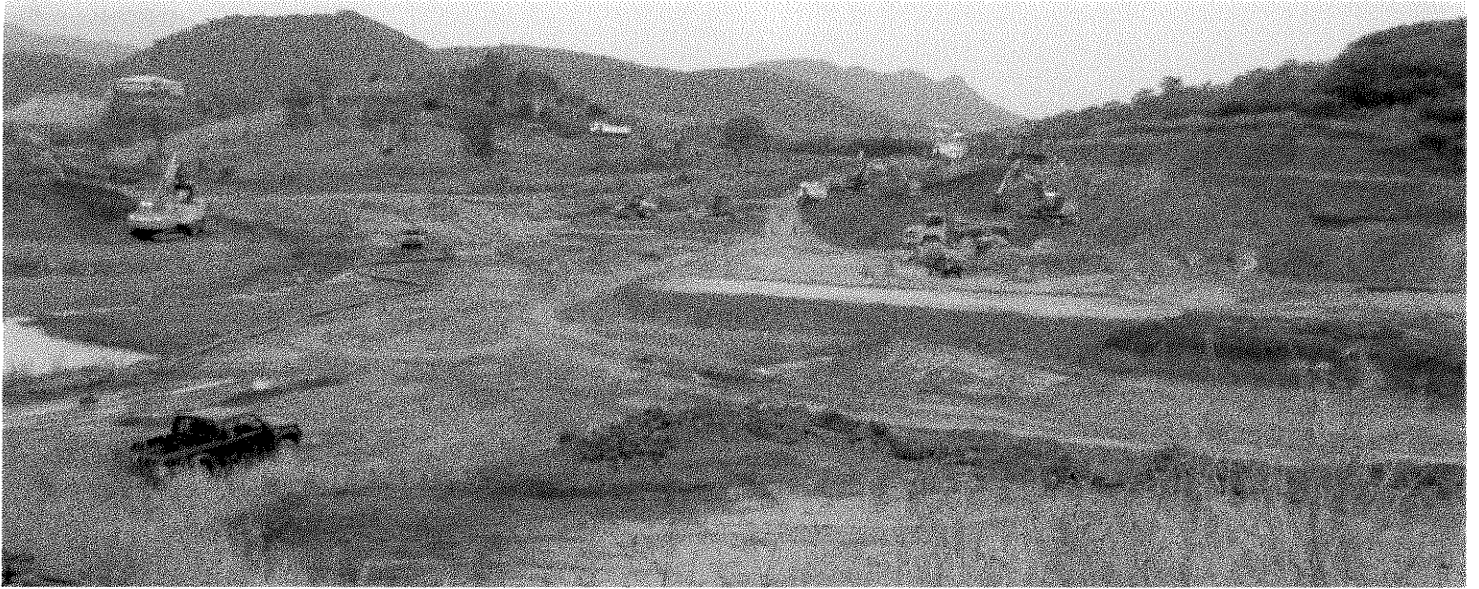
Photo 7 : travaux de terrassement du casier C
