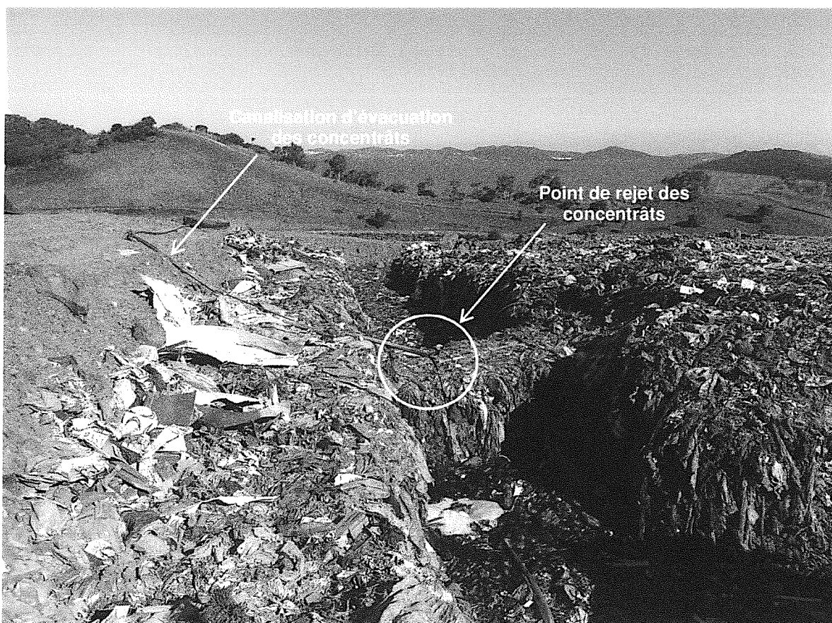
Evacuation des concentrats depuis le haut de la tranchée drainante
