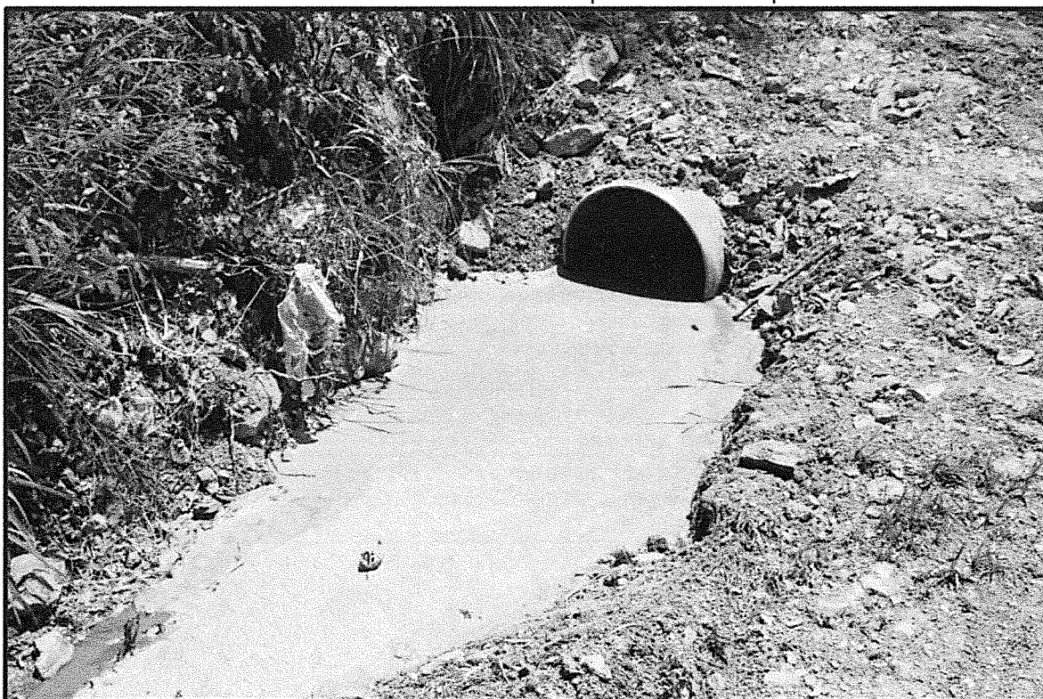
Photo 2 - Point de rétention du débordement des matières de vidange dans le fossé pluvial
