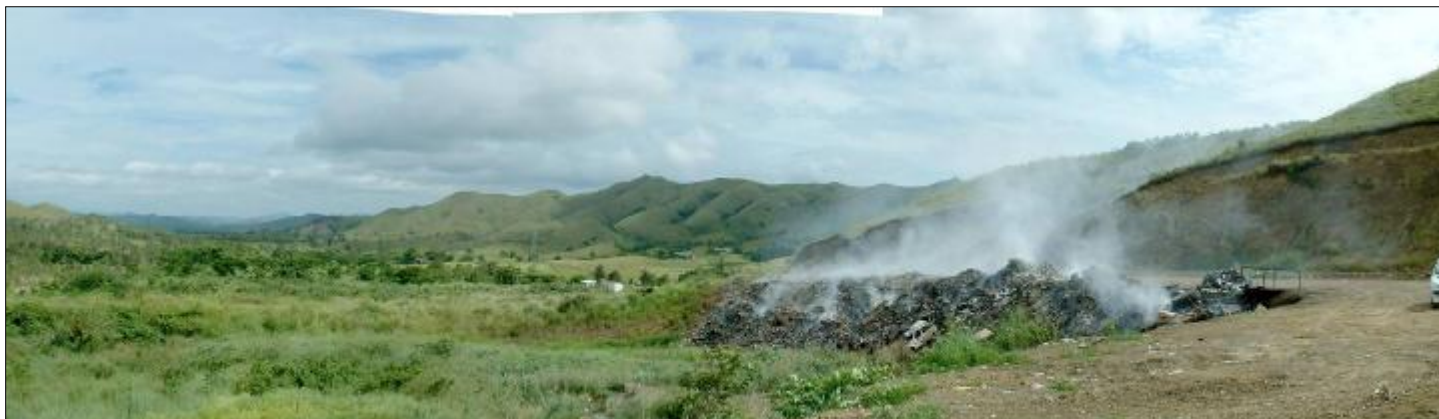
Photographie n°1 : Vue du site de projet depuis le stock principal de déchets du dépotoir actuel
