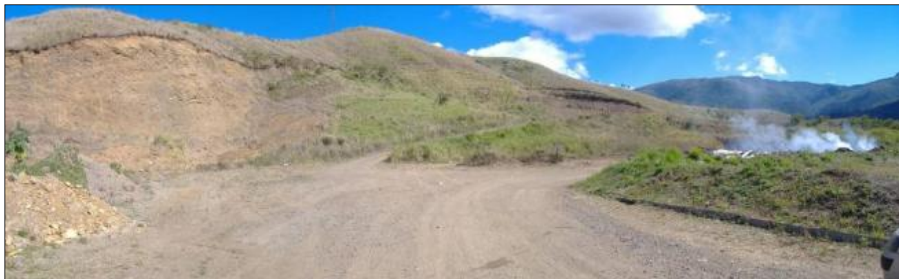
Photographie n°2 : Vue du site de projet - Entrée du dépotoir actuel
