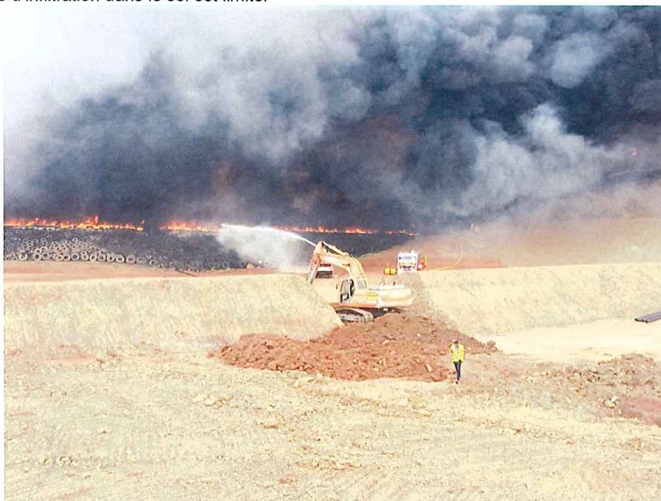
Cliché 1 : mise en place du bouchon argileux
