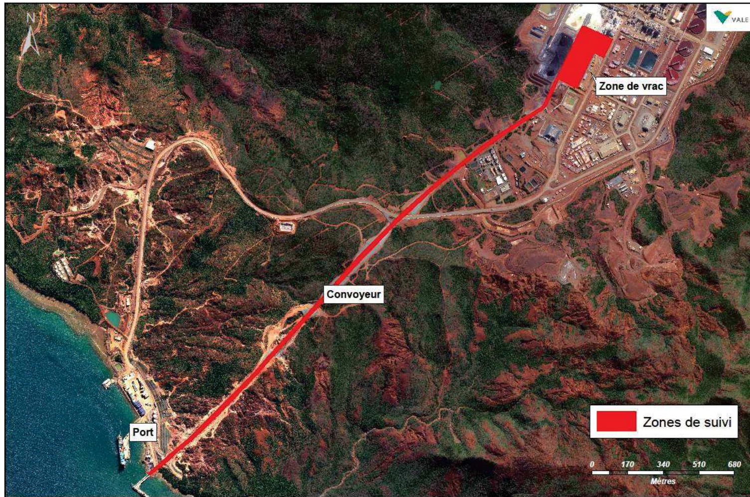
Suivi des zones d'intrusions potentielles d'EEEV via le transport et le stockage de calcaire sur le site de VALE NC
