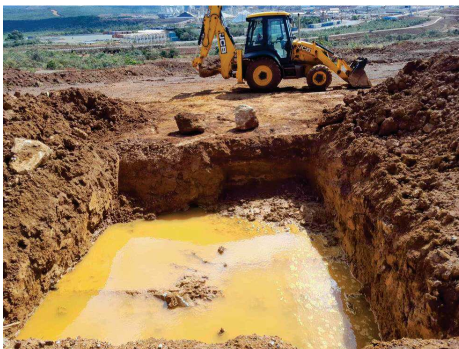
Photo : Réalisation d'une fosse d'enfouissement pour les déchets verts issus des opérations de contrôle de EEEV sur le site industriel de PRNC, 2022.
