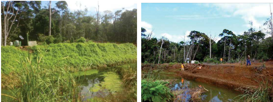
Photos : Travaux de contrôle du Mikania micrantha sur le bassin U7 (avant et après)
