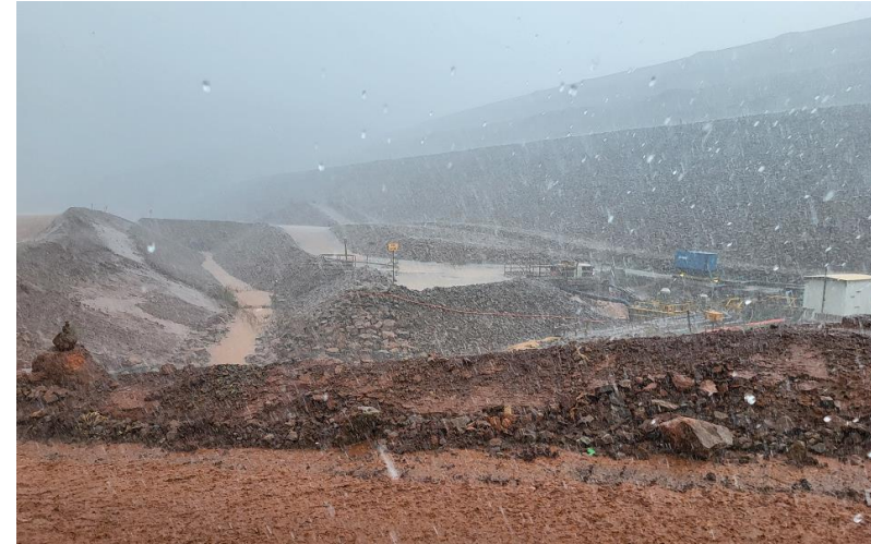
Vue des drains de pied de berme 1
