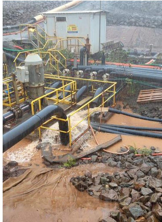
Retour OT vers pump pit - 3 pompes en fonctionnement
