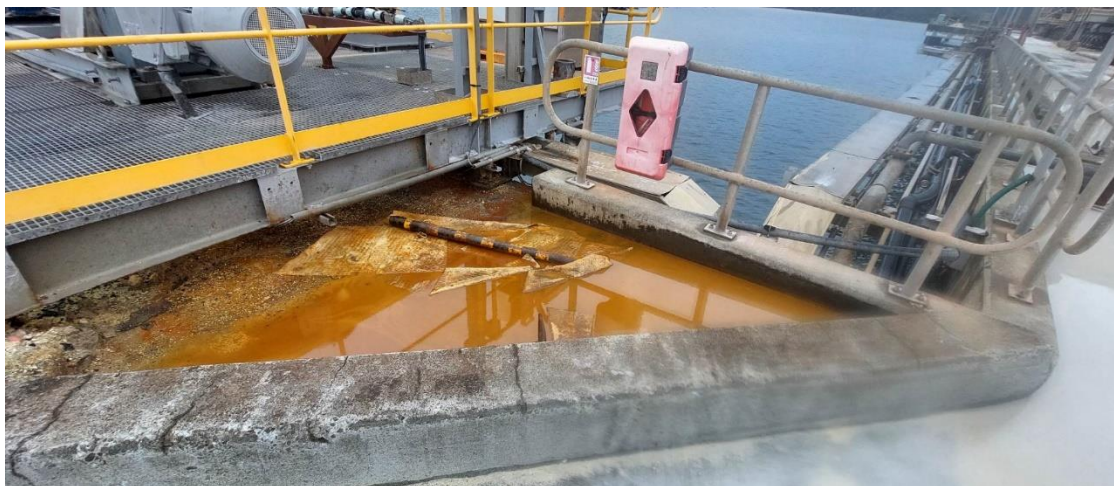
Résidus d'hydrocarbures dans la rétention située au niveau de la pompe 520-PPD-004
