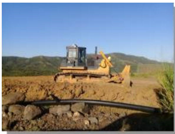
Figure 6 : Vue du bulldozer
