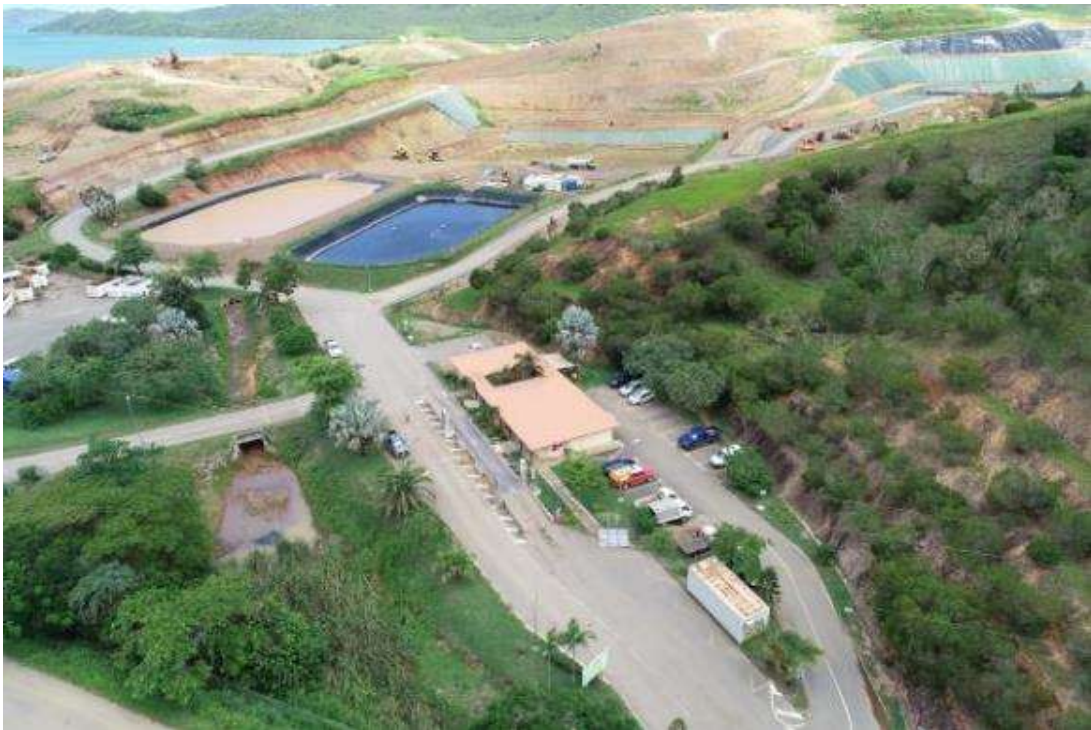
Figure 4: Vue de la bascule
