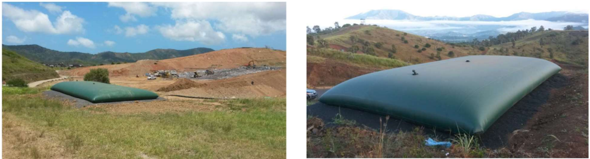
Figure 16 : Réserves souples d'eau
