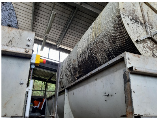
Levage de la ligne
