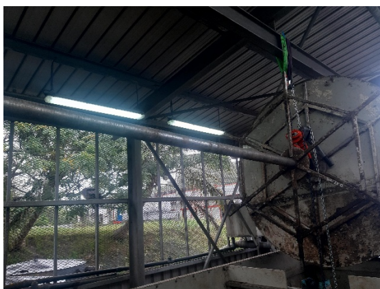
Démantèlement de la ligne entière
