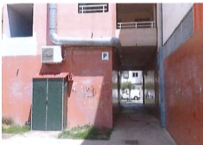
Coursives entre la rue et les parkings – Takutea 1 Takaroa
